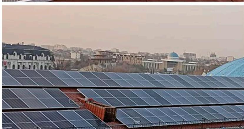
«Ўзкимёсаноат» АЖ нинг биносига 200 кВт.с қувватли қүёш фотоэлектр станцияси ўрнатилди ва ишга туширилди. Дастрабки ҳисоб-китобларга кўра станция йилига 296 400 кВт.с «Яшил» электр энергиясини ишлаб чиқаради.
